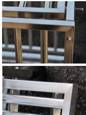
スノコの隙間寸法は約10mm
